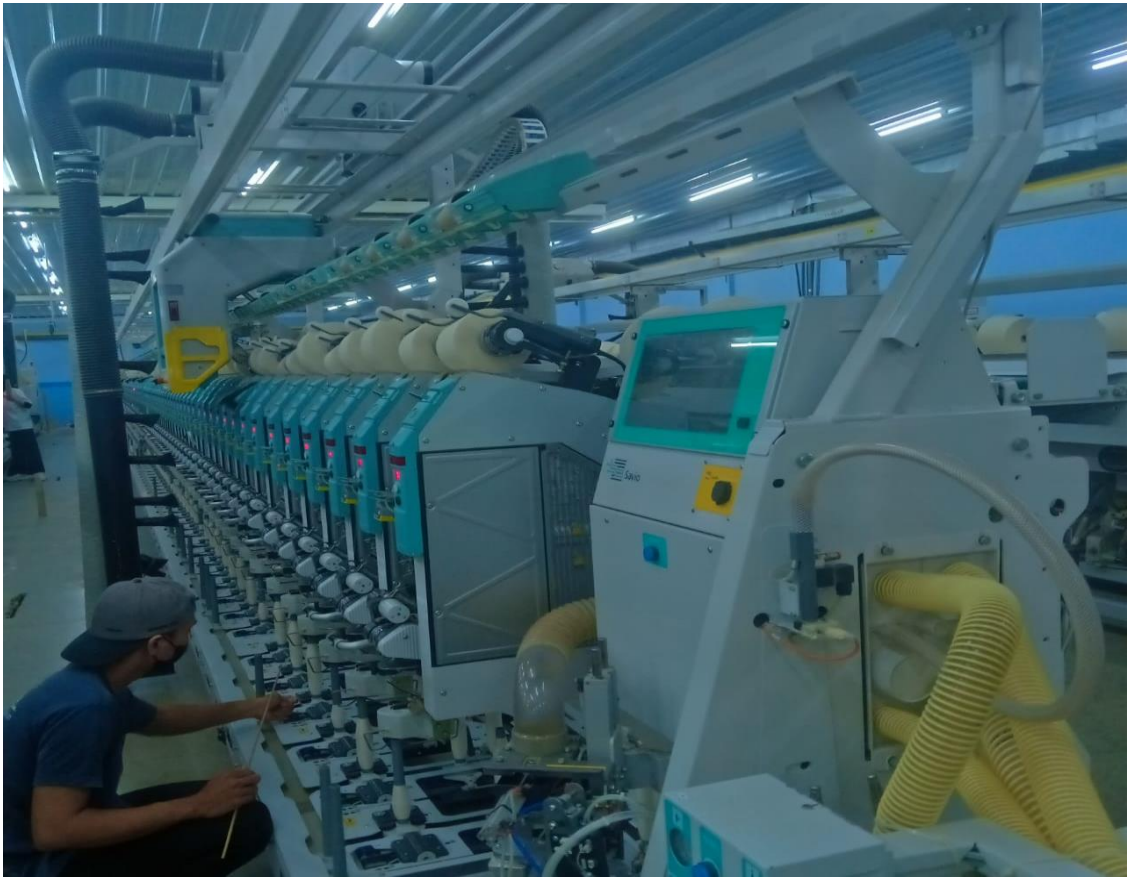
Lampiran 1 Mechanic sedang mengecek mesin
